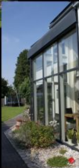
Einfamilienwohnhaus mit Wintergarten, Rhede
