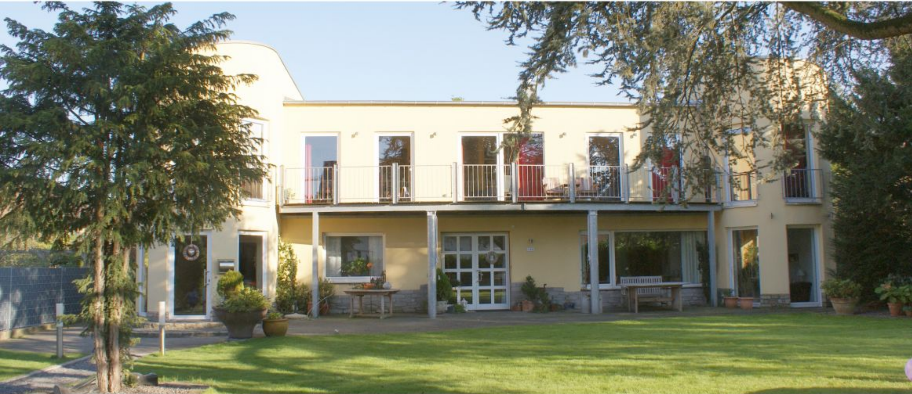
Aufstockung eines Ein- zum Zweifamilienwohnhauses, Bocholt
