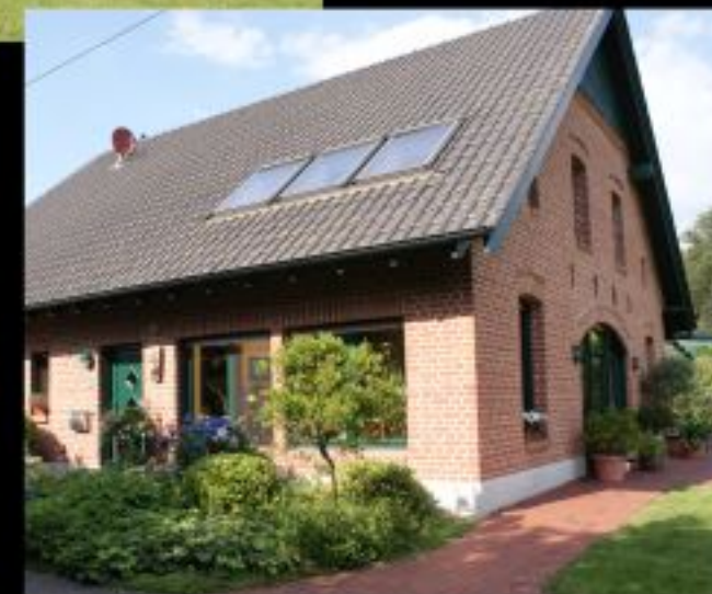
Um- und Ausbau eines Wohn- und Wirtschaftsgebäudes Bocholt
